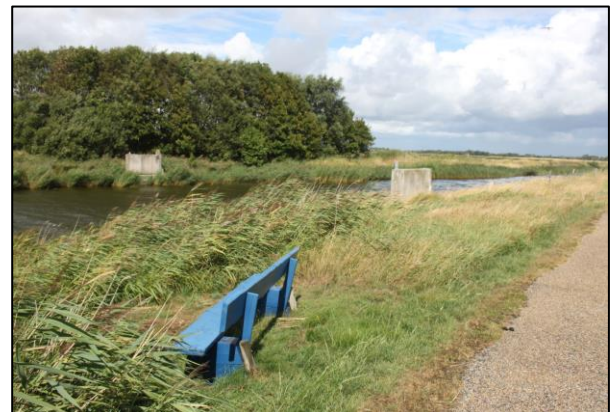
Pfeiler der alten Hemenswarftbrücke (Foto: Dirk Jensen)
